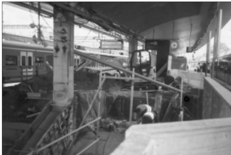
Baustelle Münster Hauptbahnhof. Foto: Franz Maxwill
