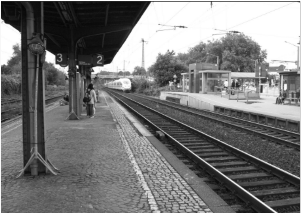
Die bunte Ansammlung von unpassenden Bahnsteighöhen im Bahnhof Oberhausen-Sterkrade soll durch zwei neue 76 cm hohe Mittelbahnsteige ersetzt werden. Foto: Jochen Schönfisch
