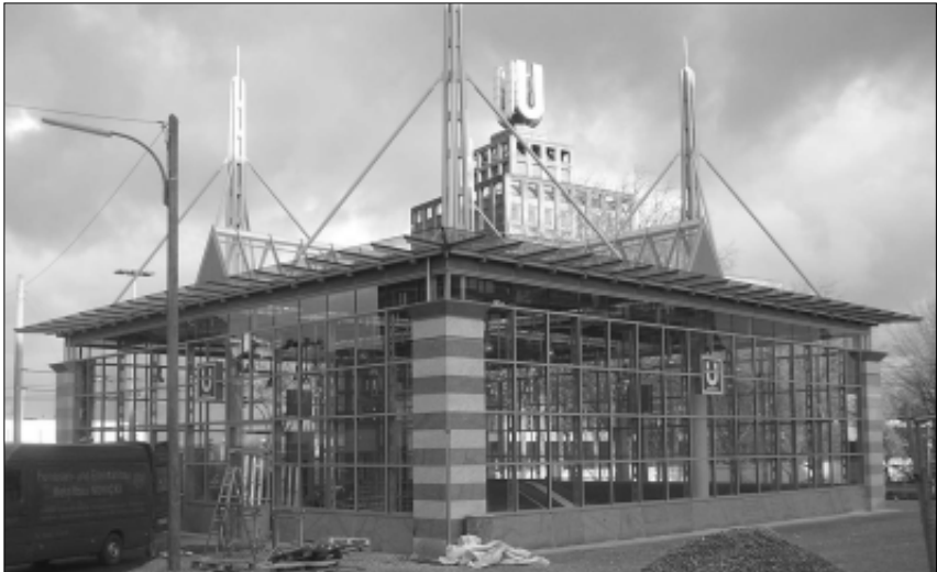
Klotzen statt kleckern: Das neue Empfangsgebäude des U-Bahnhs Westentor bereichert das Stadtbild.
