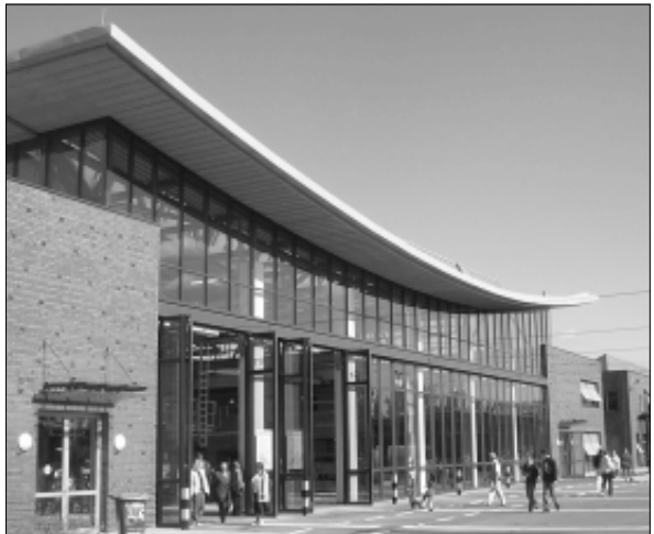
Die Hauptwerkstatt an der Engelsburger Straße. Eindrucksvolle Architektur, die den Fahrgästen über optimierte Betriebsabläufe zu Gute kommen sollte. Foto: Oliver Stieglitz
