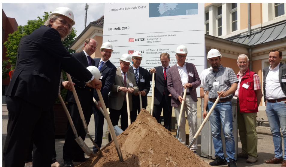
Spatenstich für den RRX-Umbau am Bahnhof Oelde. Foto: Franz Maxwill
