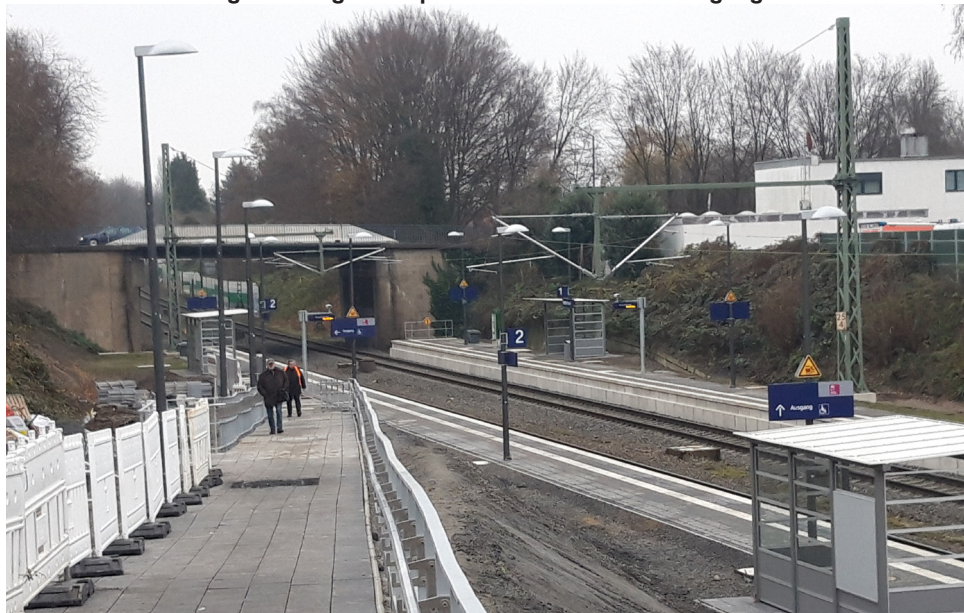
Haltepunkt Herten (Westf), Zugang von der Staakener Straße Foto: Dirk Grenz
