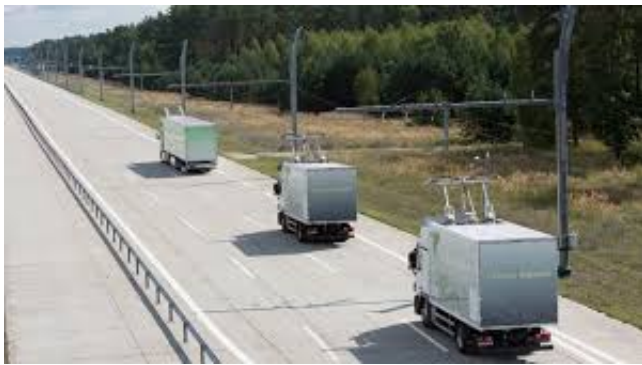
Oberleitungs-Lkw auf Autobahnen
